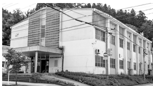
解体前の旧会館
